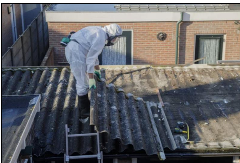
Imagen 5: Retiro planchas ondulada de asbesto cemento en cubierta.
