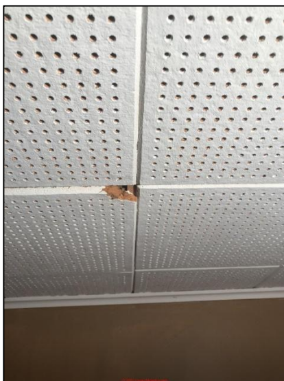
Imagen 14 y 15: Planchas livianas de cielo, daño leve 61 (izquierda), daño significativo por humedad 62 (derecha).
