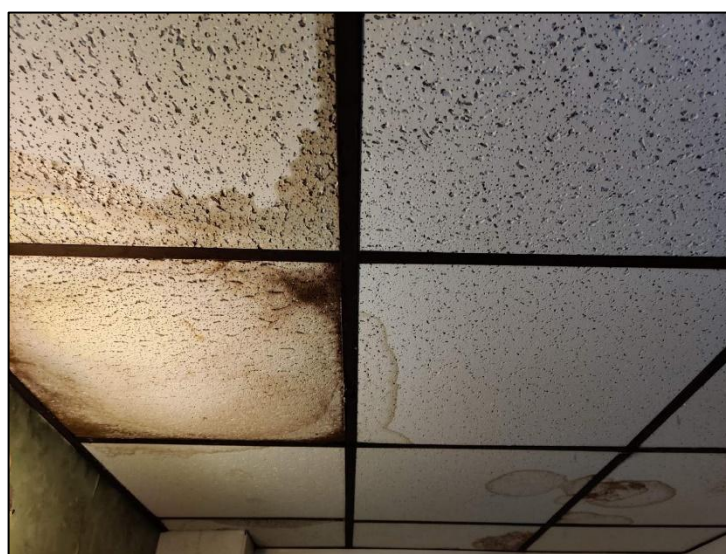
Imagen 14 y 15: Planchas livianas de cielo, daño leve 61 (izquierda), daño significativo por humedad 62 (derecha).
