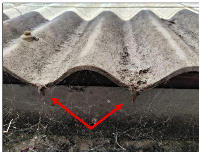
Imagen 1 y 2: Banderita, canaleta con polvo contaminado y estalactitas en los bordes de los valles de la plancha.
