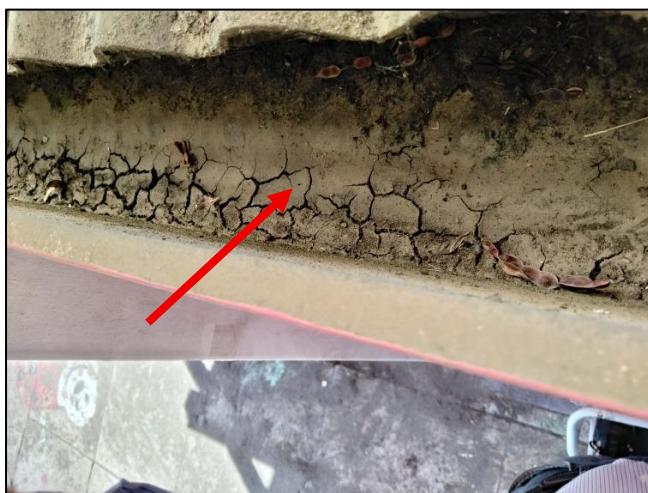
Imagen 1 y 2: Banderita, canaleta con polvo contaminado y estalactitas en los bordes de los valles de la plancha.
