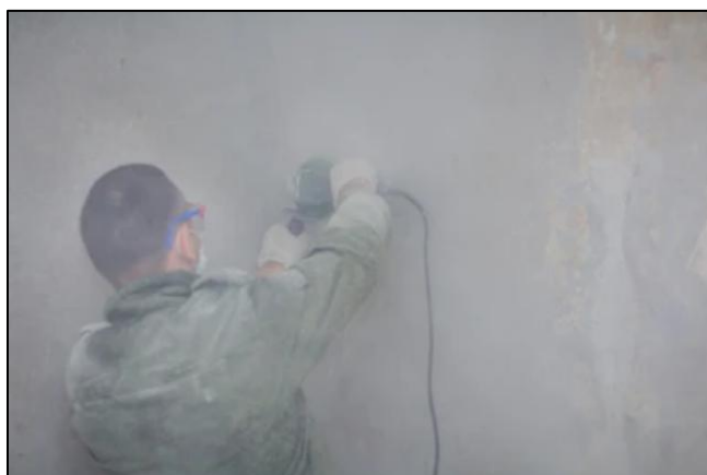
Imagen 2: Exposición ocupacional, lijado mecánico de un muro.
