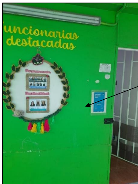
Imagen 12 y 13: Pintura con crisotilo en circulación exterior, jardín JUNJI, espectrómetro NIR.
