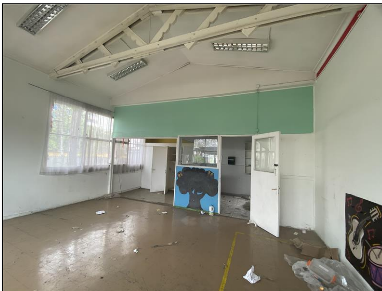
Imagen 16: Pavimentos de vinil asbesto en sala de actividades en jardín JUNJI para reposición.
